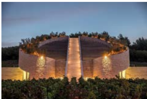
Figura 1. Cantina Petra, Suvereto (Li) (fonte: archivio fotografico Cantina Petra)
